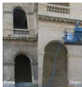
Prima Dopo Pulizia facciata
