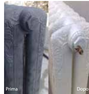
Prima Dopo Rimozione della vernice
