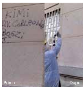
Prima Dopo Pulizia facciata - rimozione graffiti
