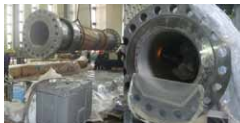
Sabbiatura abrasive con ghiaccio secco all'interno di un tubo di acciaio
